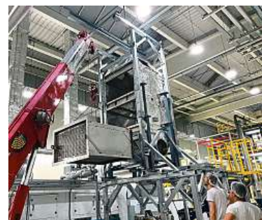
Montáž trubkovnic výměníku.
