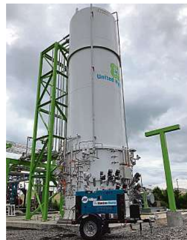
Nádrž zvaná Coldbox, kde dochází ke změně skupenství vodíku na kapalný působením kapalného helia. To jediné je ještě chladnější než vodík. Vodík má -253 a helium -269 stupňů Celsia.
